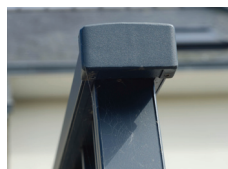
BENN (KAY) Embout aluminium laqué à la couleur du garde-corps
